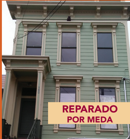
380 San Jose despues reparaciones
