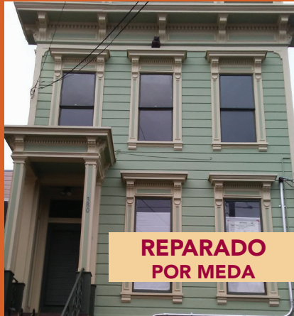
380 San Jose despues reparaciones
